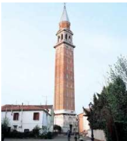
valutazione delle vibrazioni provocate dalle campane
