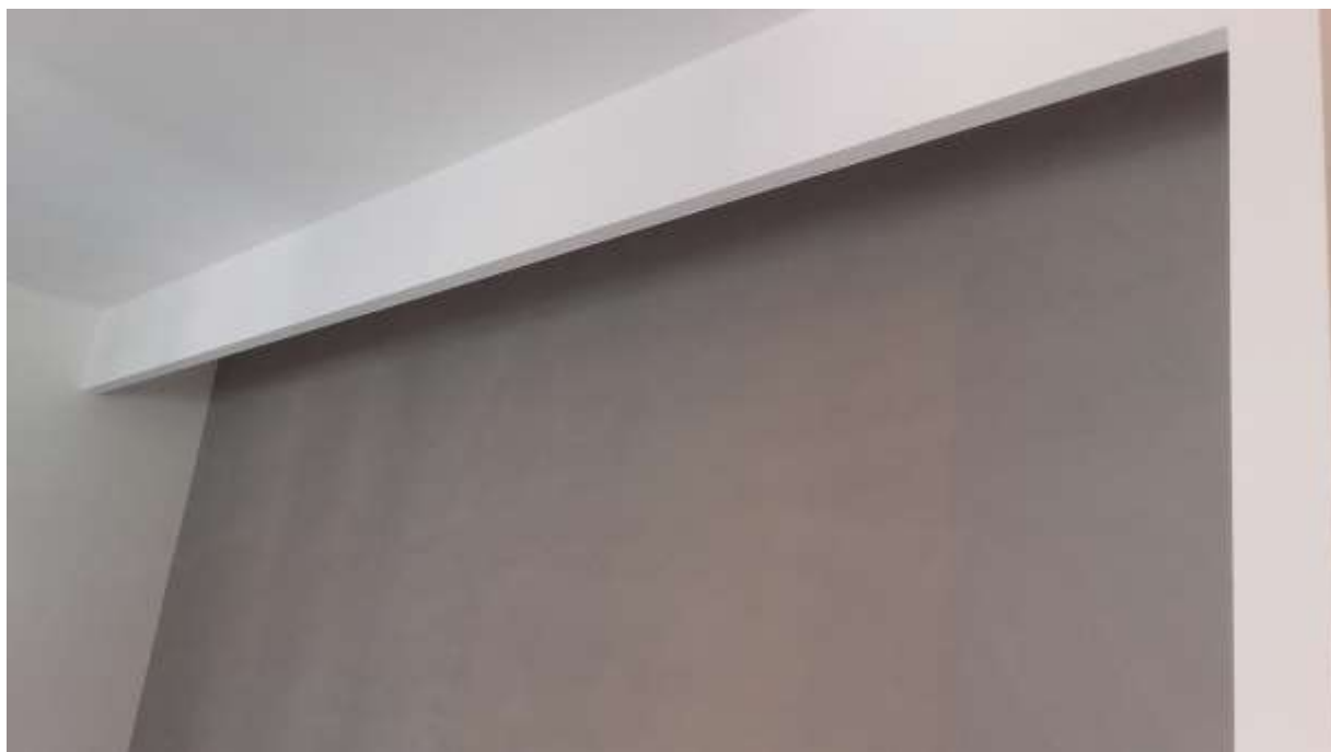
Rasatura del soffitto con riporti in cartongesso
