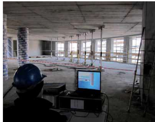
applicazione del carico su solaio con metodo a spinta
